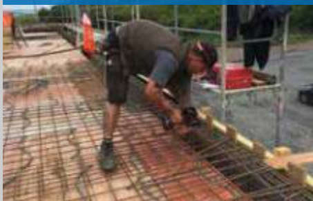
Izrada armature podova
