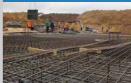
Izrada armature temelja
