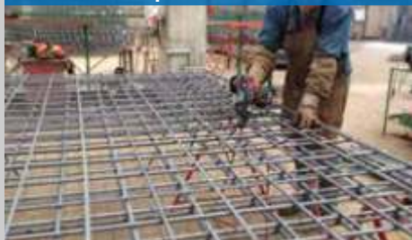
Spajanje predgotovljenih panela
