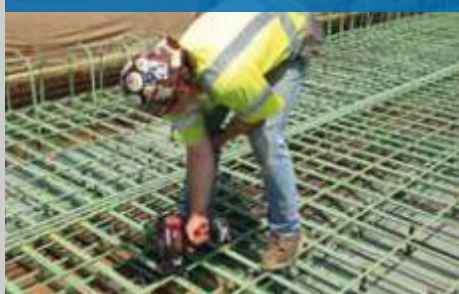
Spajanje predgotovljenih panela
